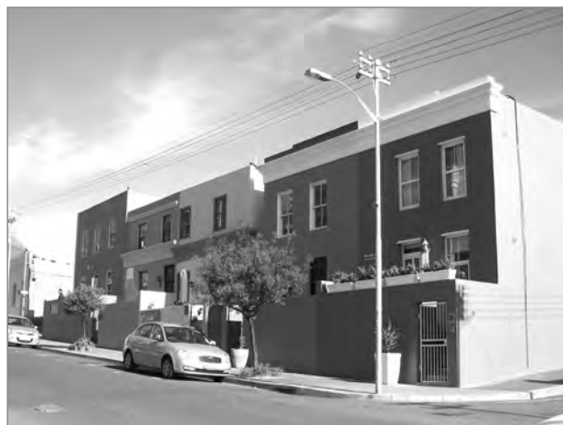
Slika 3: Obnovljene hiše v soleski Bo-Kaap s pročelji prvotnih hiš (foto: Nico Kotze)
