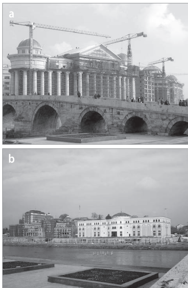
Slika 4: a) Stavba ustavnega sodišča, državnega arhiva in arheološkega muzeja med gradnjo; b) stavba muzeja makedonskega boja in starega gledališča. Te stavbe spadajo med najpomembnejše projekte v mestnem središču v sklopu projekta »Skopje 2014« (foto: Jasna Stefanovska).
