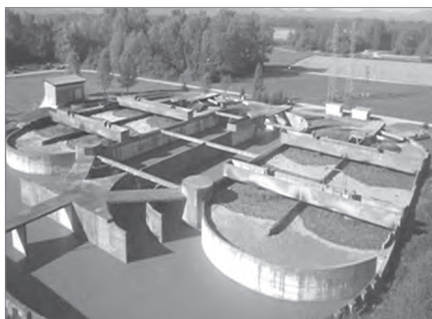
Slika 7: Porušena in za polovico zmanjšana kapaciteta za denitrifikacijo že leta 1980 zgrajene čistilne naprave na Ptujju za 106.000 populacijskih enot
