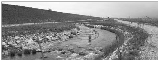
Slika 5: Prehod za vodne organizme ob HE Brežice (vir: Rožman in Hribar, 2019)
