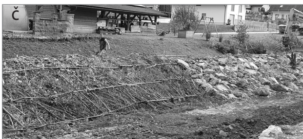
Slika 6: Tehnike sanacije rečnih brežin: (a) zložba kamen v betonu, (b) kombinacija suhe zložbe in lesene kašte, (c) kombinacija pilotov, prečnih kolov in skal, povezanih z jeklenico, (č) pokrivanje pobočja z rastlinami (foto: Franc Vidic).
