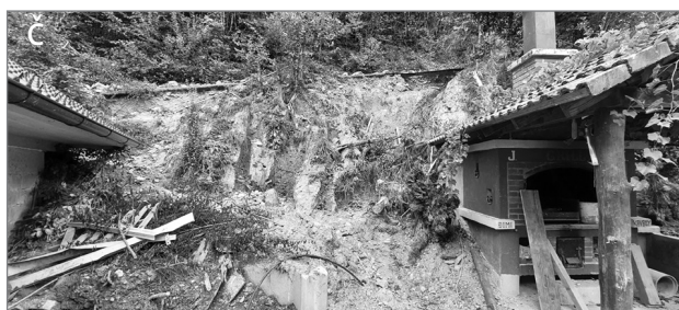
Slika 4: Proženje zemeljskih plazov je pogosto posledica antropogenih dejavnosti: (a in b) pomanjkljivo urejeno odvodnjavanje ceste, (c) opuščene njive, (č) slabo zaščiten izkop (foto: Franc Vidic).
