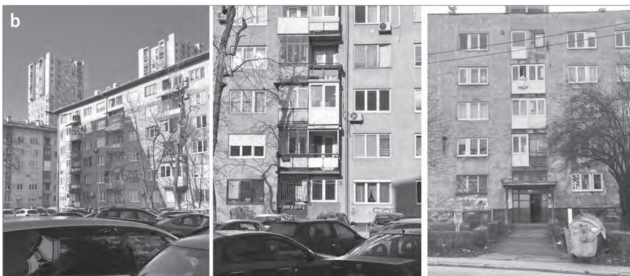
Slika 3: a) tipologija stanovanjskih stavb v Bosni in Hercegovini (prirejeno po: Arnautović-Aksić idr., 2016); b) trenutno stanje zgradb na proučevanem območju (foto: avtorji)
