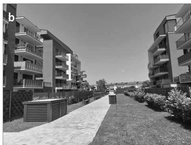
Slika 4: Ureditev pešpoti v (a) socialistični večstanovanjski soseski S-23 v Mariboru in (b) v postsocialistični večstanovanjski soseski Novi vrtovi v Mariboru (foto: Boštjan Kerbler)
