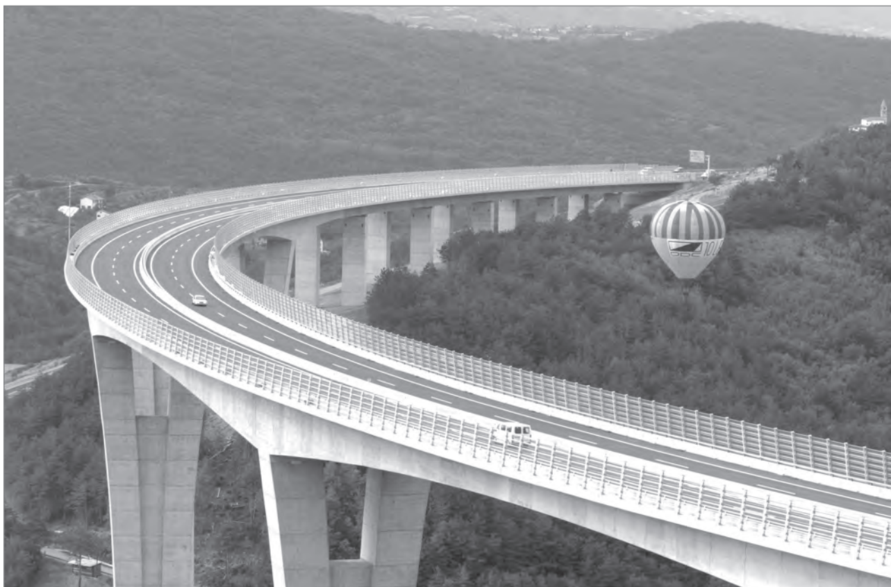
Slika 15: Viadukt Črni Kal – tik pred otvoritvijo (foto: Ferucio Hrvat, 2004)
