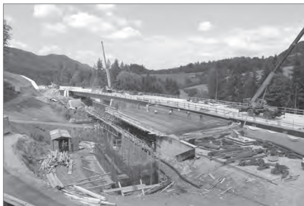
Slika 14: Gradnja AC preko Trojan (foto: arhiv Projekta Trojane 2002)
